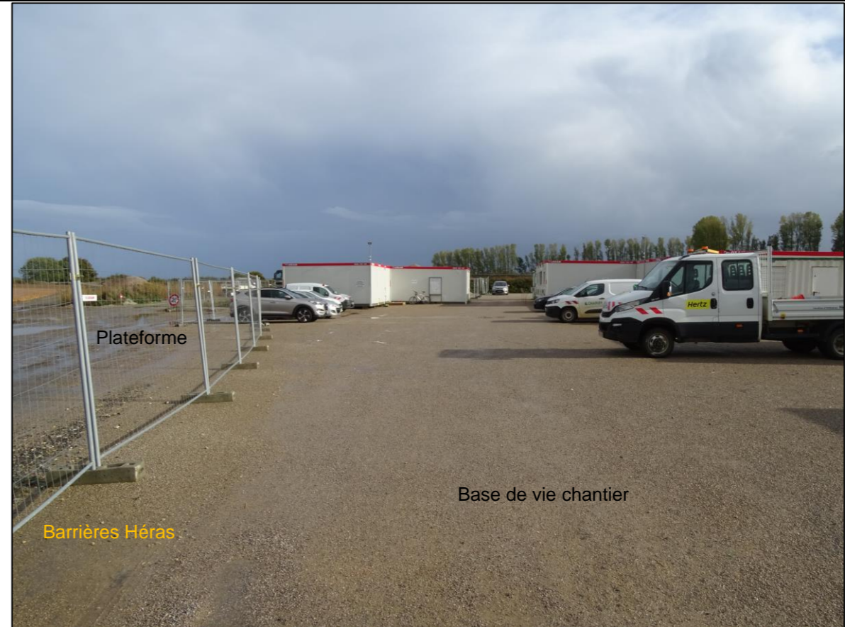
Figure 17 : Barrières Héras entre la plateforme et la base de vie chantier
