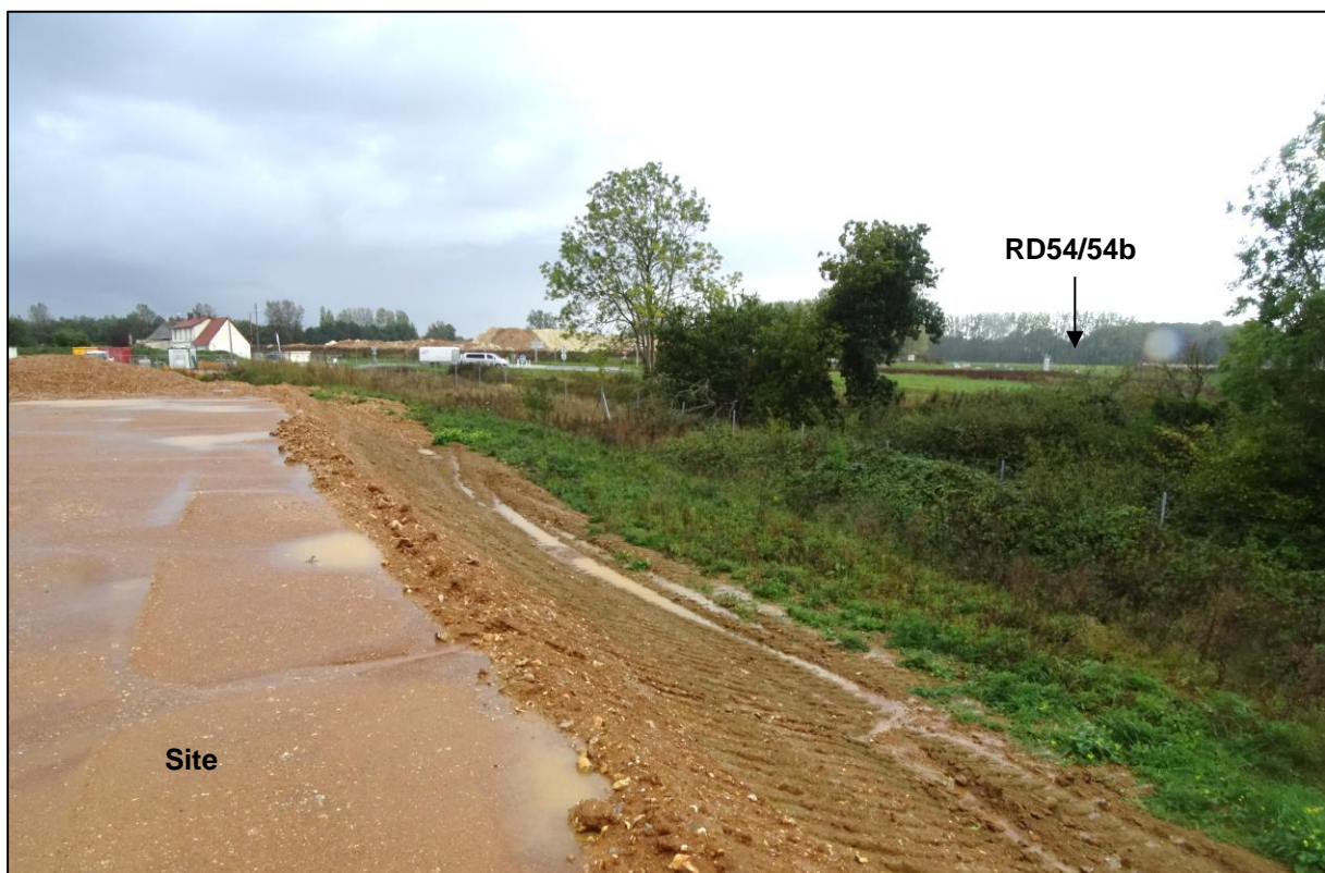
Figure 22 : Vue sur la RD54/54b et le carrefour giratoire du Gruchet depuis la plateforme
