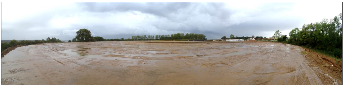
Figure 4 : Vue sur la plateforme existante depuis le secteur nord/nord-ouest
